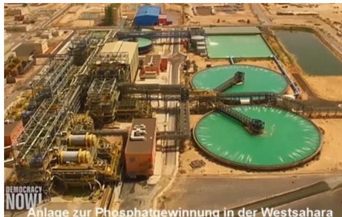
Anlage zur Phosphatgewinnung in der Westsahara
